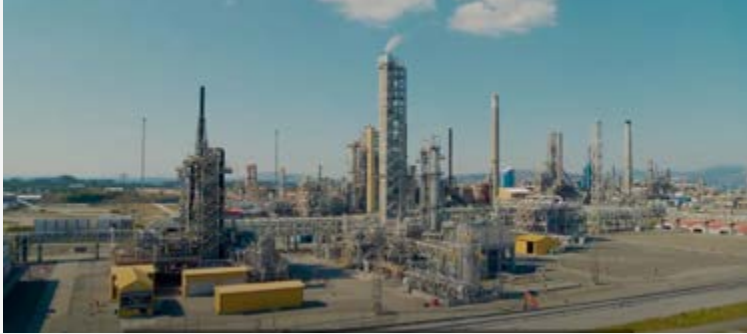
الشكل 4.4: مركز تكنولوجيا CO 2 مونجستاد بالنرويج. (برعاية مركز تكنولوجيا مونجستاد و tcmda.com )
