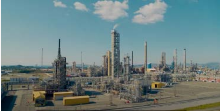
Figura 4.4: Centro de Tecnologia de CO 2 de Mongstad, Noruega. (Cortesia do Centro Tecnológico de Mongstad, tcmda.com)
