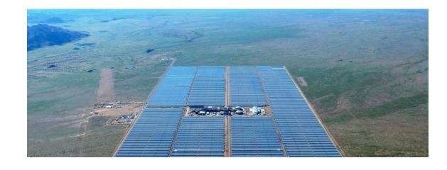
Ce que vous voyez ci-dessus est une photo d'un projet solaire de 50 MW Khi et de 100 MW Kaxu où on a combiné la technologie de l'électricité solaire concentrée avec la vapeur saturée et un stockage de sels fondus.
